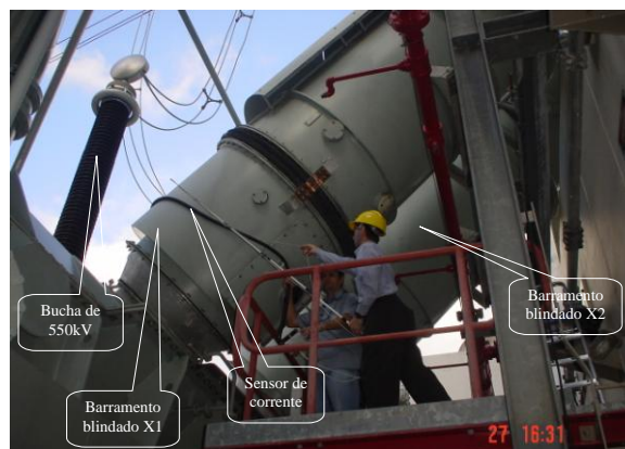
Figura 3 – Segmento de Barramento sem Blindagem Magnética sob Medição.
